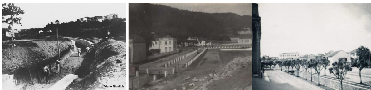
Figuras 2, 3 e 4: Canalização Rio da Bulha e Avenida do Saneamento. Fonte: Muller, 2010 (Figura 2); Santos, 2009, pp. 511-512 (Figuras 3 e 4).
